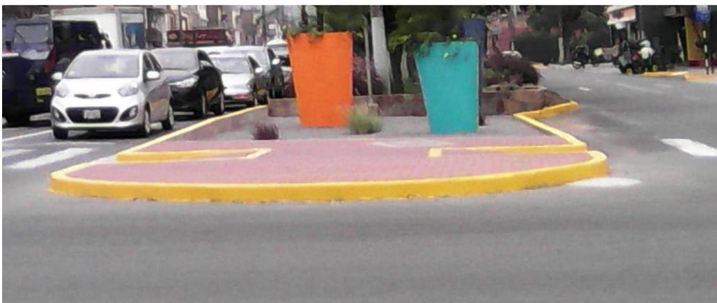
9.- Cambio de geometría e implementación de giro, ampliando medio carril para el volteo a la izquierda de la Av. La Molina hacia la Av. Los Constructores.
