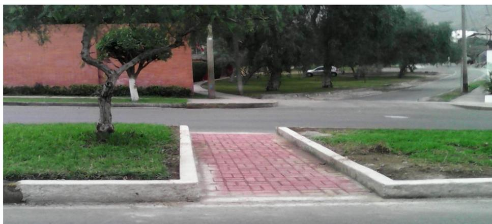
4.- Ejecución de pases peatonales con adoquinado en la Berma Central de la Av. Rinconada del Lago.
