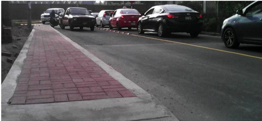
11.- Implementación de camino adoquinado, confinado con sardineles de concreto, en la Ca. Los Nogales, altura del cruce con la Av. Las Palmeras.
